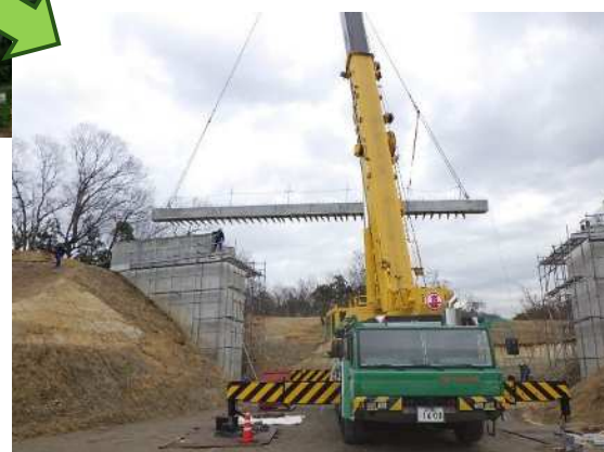
新しい橋桁の架設 (施工イメージ写真)
