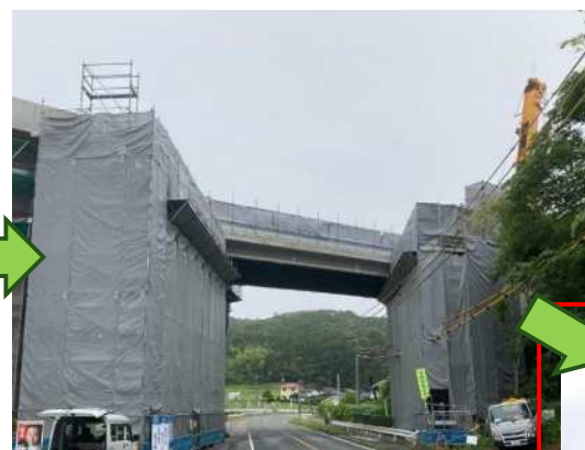
古い橋桁撤去後
